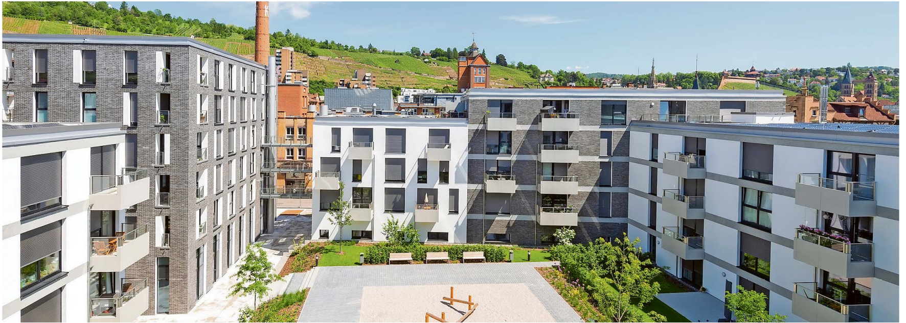
„Béla“ war der erste Gebäudekomplex, der von RVI im Esslinger Stadtquartier Lok.West errichtet wurde.
